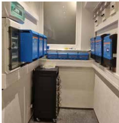
Die Steuerung der PV-Anlage mit Batteriespeicher
